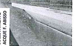
CANNARA (PG) ARGINATURA CON TERRE ARMATE SUL T. ATTONE IN SX IN VIA DESTRA TOPINO IDRAULICA
